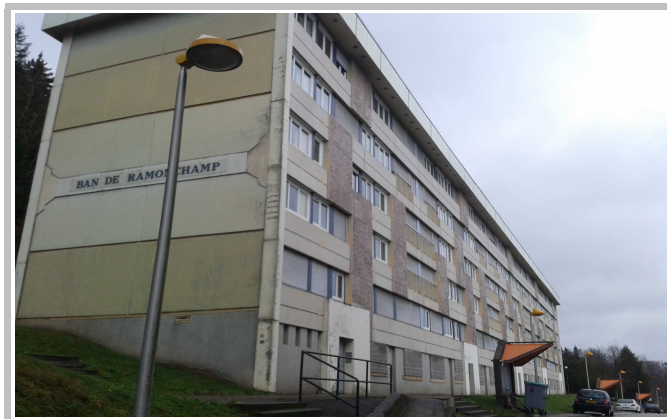
Ban de Ramonchamps (démolition prévue)
